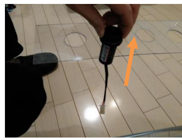
内側から本体を入れ、外側からゴムリングキャップ付きリング、外リングをはめて固定します
